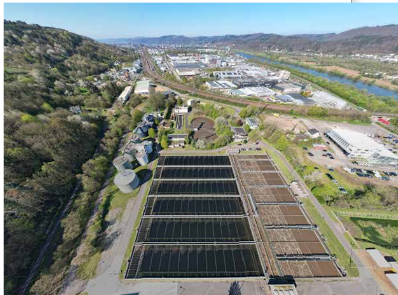
Kläwerk mit Nachklärbecken
