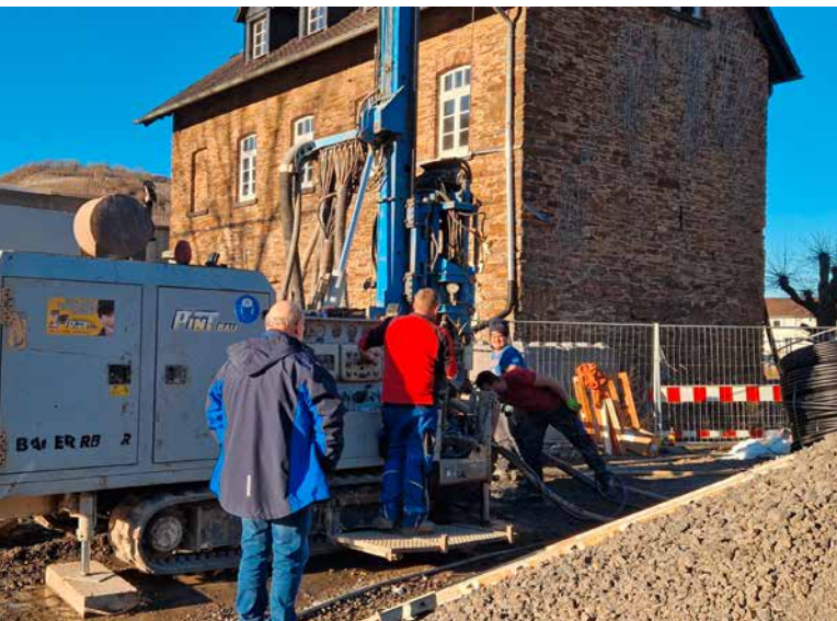
Probebohrung für kalte Dorfwärme in Rech
